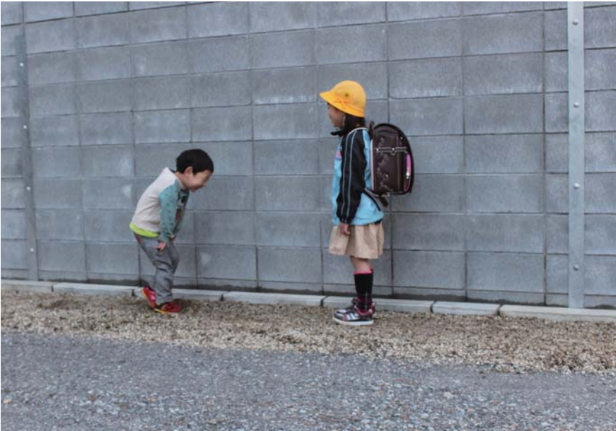
● 耐震補強 道路側
