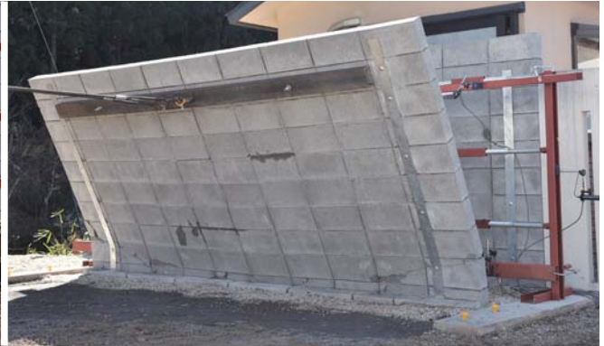
● FITパワーで耐震補強したブロック塀 牽引荷重約17kNで75mm傾き始めたが、牽引荷重最大約28kNでも転倒せず7倍超える強靭さを実証
