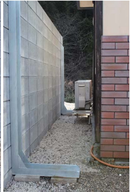
● 耐震補強 敷地側
