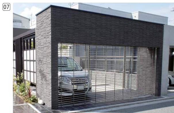
タイル等貼り付け仕上げ ※ こんなに素敵に仕上がりました。
