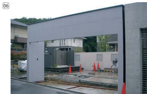
現場据付完了 下地状態で電動製品【シャッター、照明、電気錠等】の作動を確認 注 立会者様に必ず確認して頂きます。
