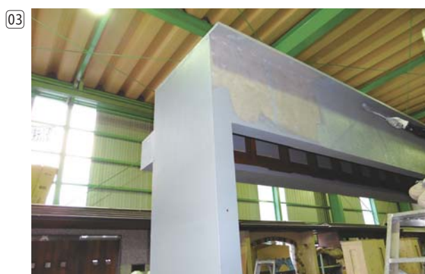
防水工程（5回塗り） GL 下トップコート及びエポキシ処理
