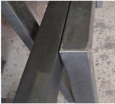
FIT GUARD『フィット・ガード』は強固で安全な鉄骨構造です。しかし、鉄骨をそのまま着色してもいずれは錆が出てしまいます。そこで当社FITシリーズで優れた効果を発揮している防水工法を鉄骨に施し厚い防水層を形成させます。さらに遮熱塗料を塗布することにより未長く快適に使用できる躯体となります。
