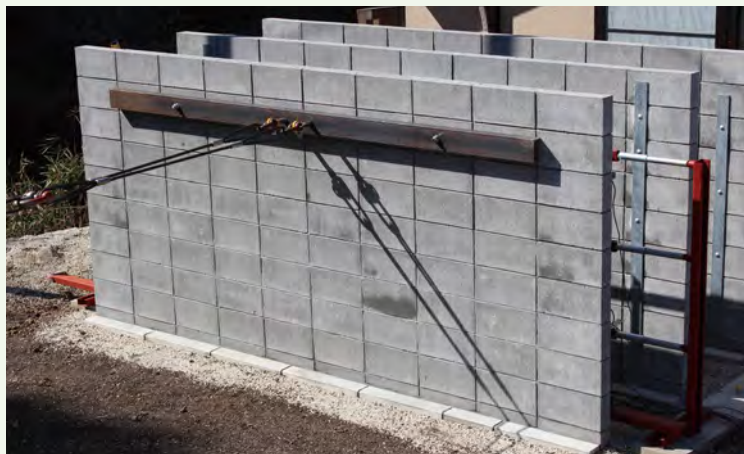
ブロック塀天板から300mm下がりワイヤーを取り付け牽引)
