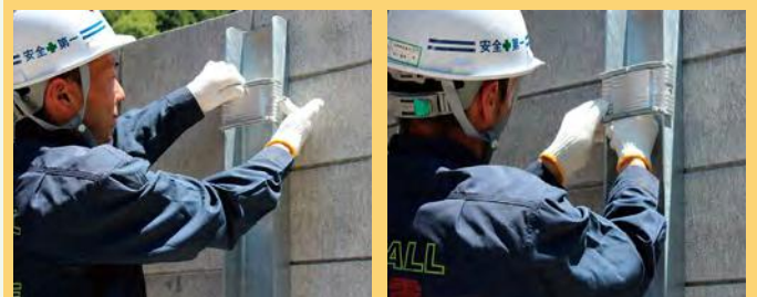
①穴合わせとビスの差し込み ② 蝶ナットで締め付け固定
