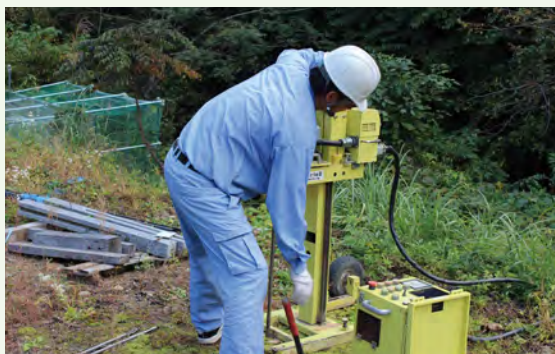
(地盤調査の状況) スウェーデン式サウンディング調査の場合 調査後SWS値をN値に換算
