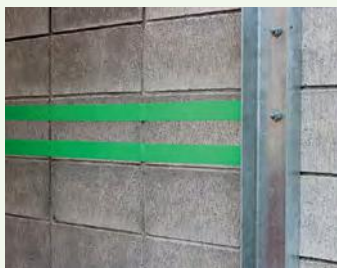
(2) 養生テープ貼り付け
