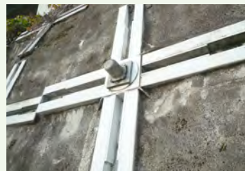
※トンネルの天井・法面の壁面に使われる工法です。
