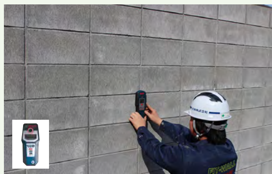
⑪ 金属探知機による鉄筋調査 下地鉄筋チェッカー（有償貸出しています）
