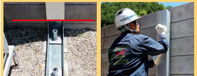
① 下辺補強部を目安にセット ② 嵌め込み
