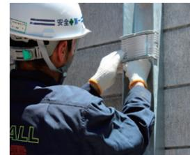
②蝶ナットで締め付け固定
