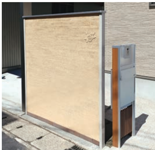
塗里壁タイプの使用例です。
