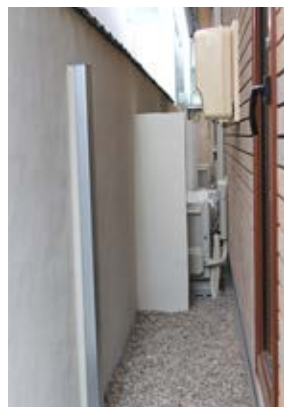
奥の控え壁は新設(CB塀) 出幅400mmで軒下の利便性が 気になる
