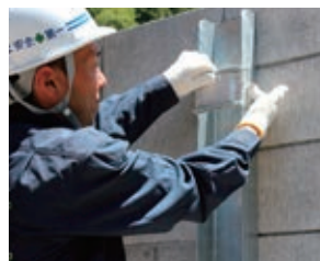
①穴合わせとビスの差し込み
