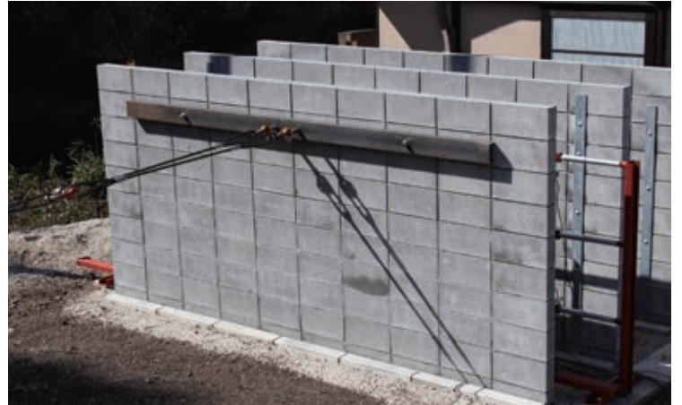
(天端から300mm下がりにワイヤーを取り付け牽引)
