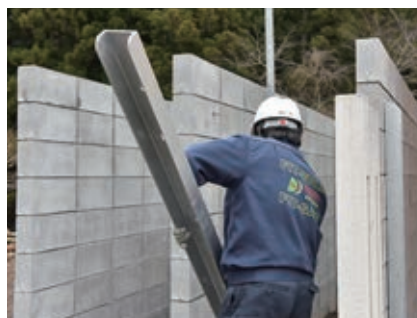
※写真は最重量、18型敷地側 アングル支柱(31kg)です。
