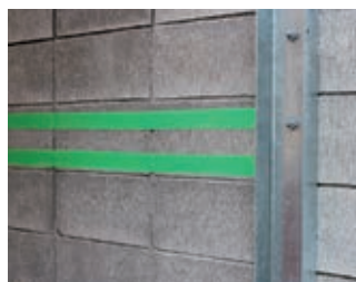
(2) 養生テープ貼り付け
