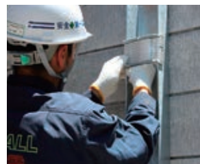
②蝶ナットで締め付け固定
