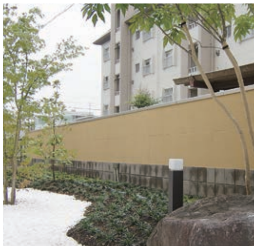
塗里壁タイプの使用例です。
