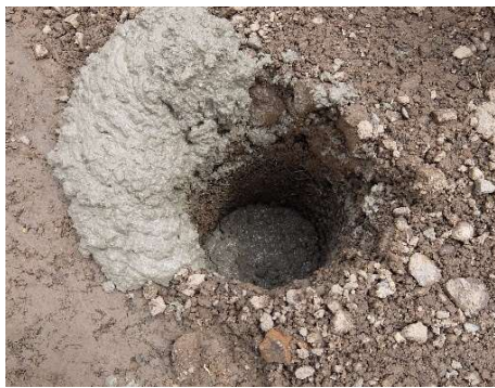
写真2：FITパワー補強CB塀施工中（ベースなし、差し筋施工）
