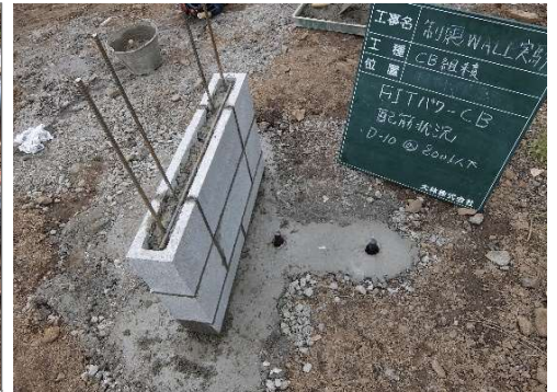
写真2：FITパワー補強CB塀施工中（ベースなし、差し筋施工）
