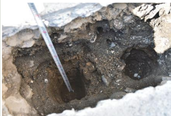
●穴の深さを確認してください。●穴の径φ180mm以上
