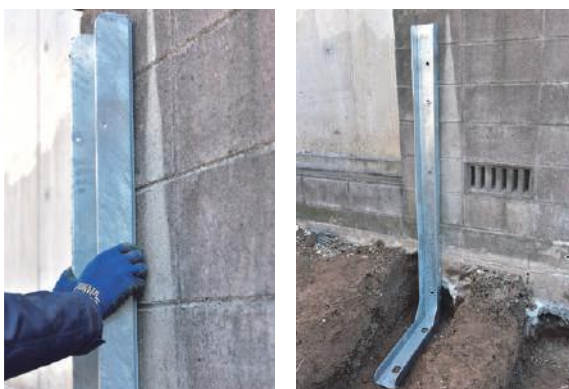
●敷地側アングル支柱の仮置き
