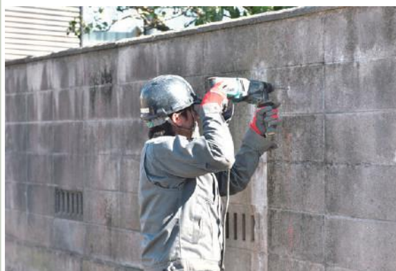
●貫通ボルト用の穴あけ (振動ドリル)φ15mm~18mm
