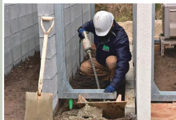
●バイブレータで空洞を無くす
