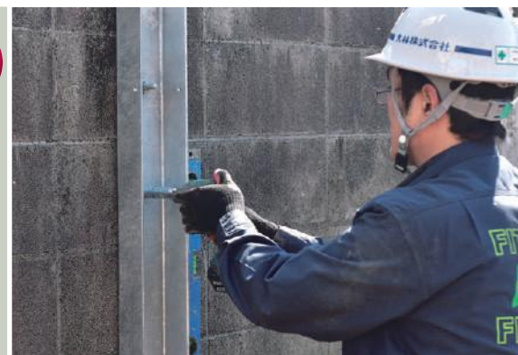
●敷地側アングル支柱をセット。角根丸頭ボルトに ワッシャーを通しナットを敷地側から締め付けて固定
