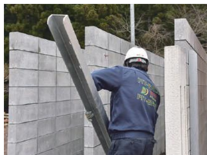
※写真は最重量、18型敷地側 アンクル支柱(31kg)です。
