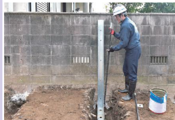
●敷地側アングル支柱を通して杭基礎坑に ロックボルト(パワースレッド)L1,500mmをセット
