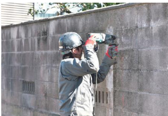
●貫通ボルト用の穴あけ (振動ドリル)φ15mm~18mm
