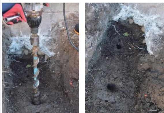
●穴掘り中 機械が斜めにならないように注意してください。
