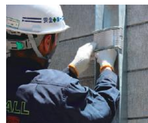
②蝶ナットで締め付け固定
