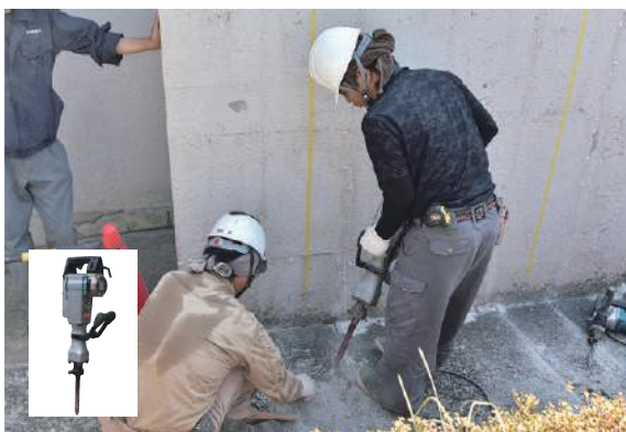
●コンクリート部分のハツリ作業 (既設ブロック塀のベース基礎のハツリ含む)
