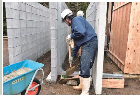
●コンクリート流し込み(標準仕様の杭基礎)
