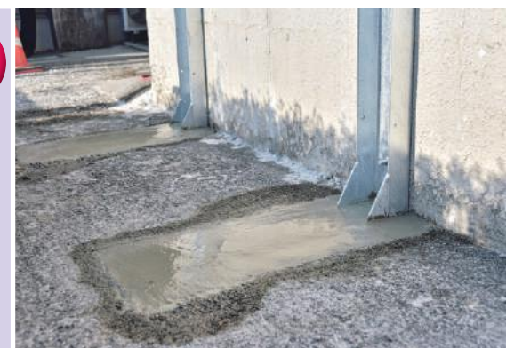
●敷地側完成 写真 FITパワー 18型アングル支柱
