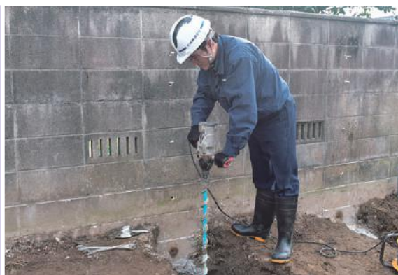
●Sモール(簡易貫通機)にて穴掘り(P15参照) φ50mm×H1,600mmを穴掘りして1セットあたり10分(1箇所5分)程度で 完了します。
