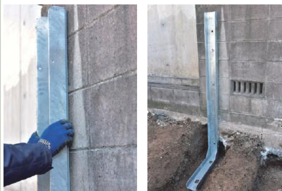
●敷地側アングル支柱の仮置き
