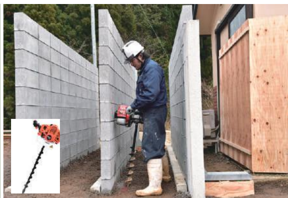
●機械による穴掘り作業
