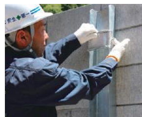
①穴合わせとビスの差し込み
