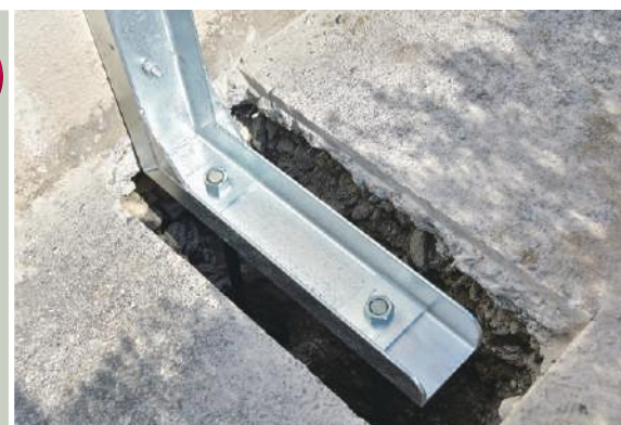
●敷地側アングル支柱を通して杭基礎坑に ロックボルト(パワースレッド)をセット
