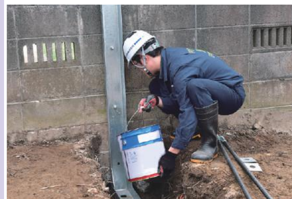
●無収縮モルタル流し込み
