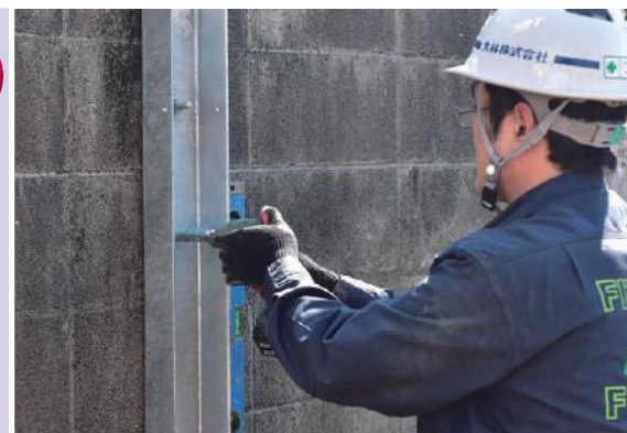
●敷地側アングル支柱をセット。角根丸頭ボルトに ワッシャーを通しナットを敷地側から締め付けて固定
