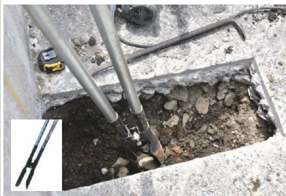
●手掘りによる穴掘り作業
