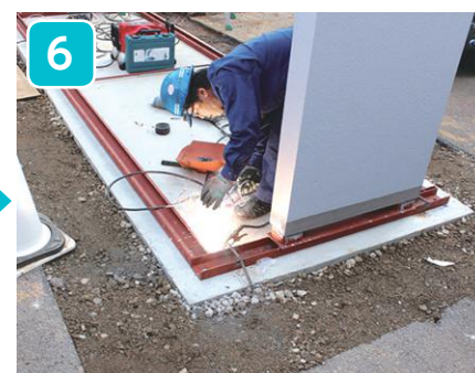
ゲート本体の溶接固定(弊社にて)
