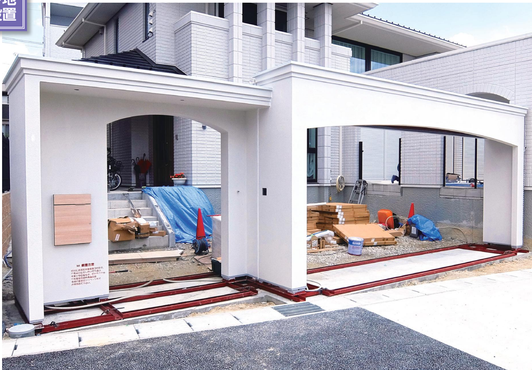
通用門とシャッターゲートを分割して納品。
