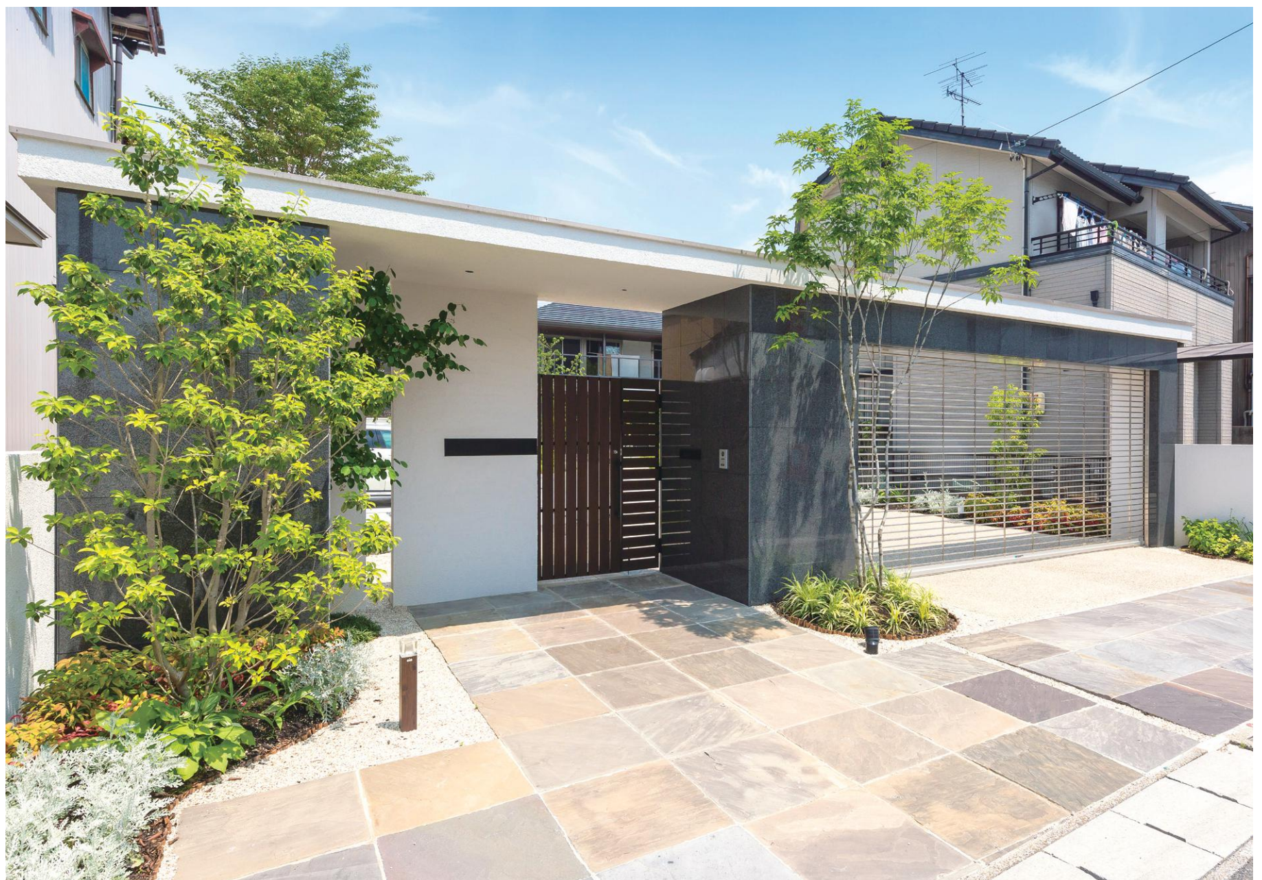
梁の幅を極力薄くすることもFIT工法なら可能です。
