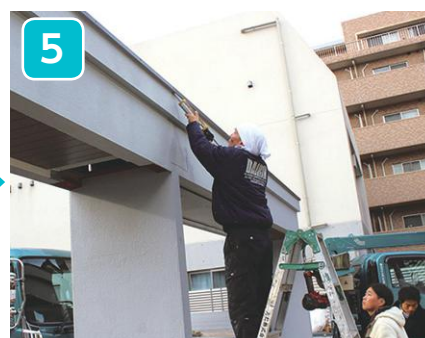
ドッキング箇所を変性シリコンで 下地調整(弊社にて)
