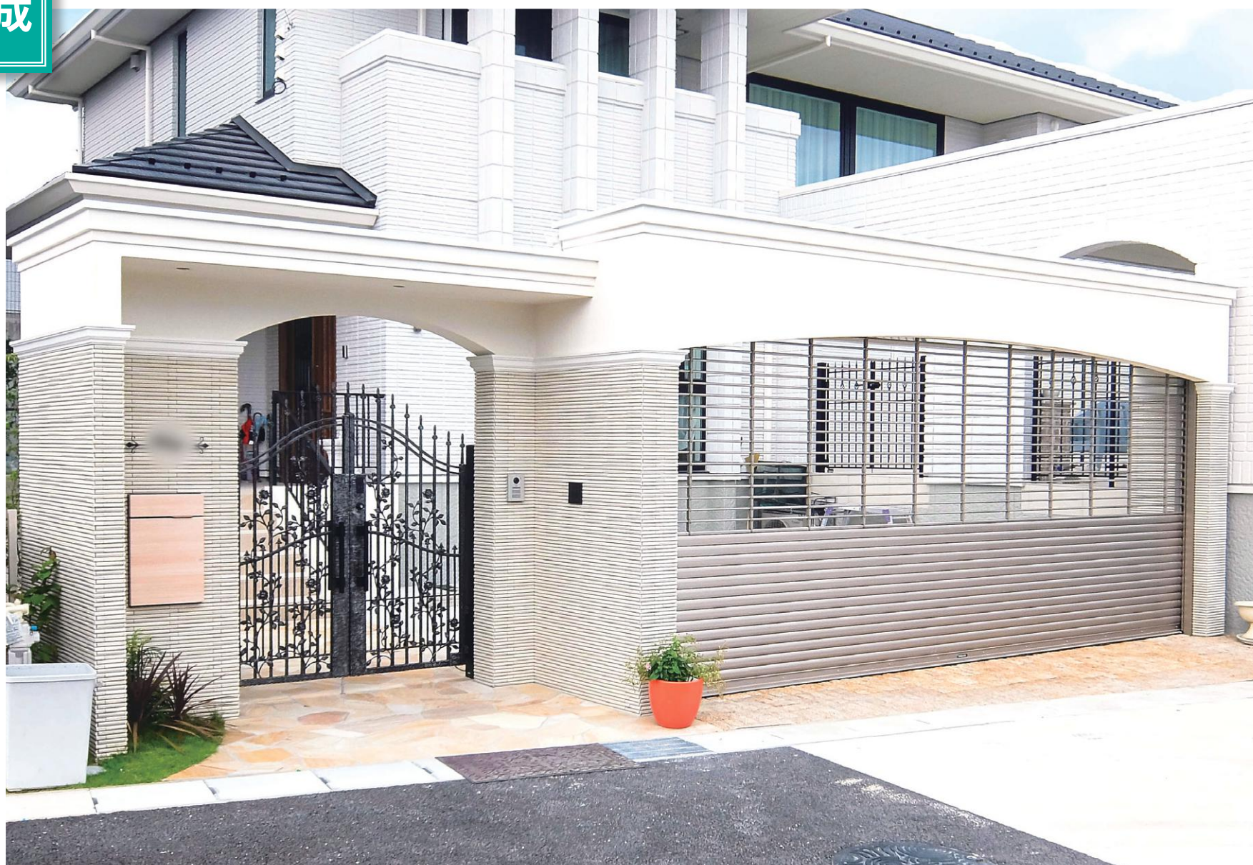
曲線を取り入れ、やわらかい印象を感じるシャッターゲート。
