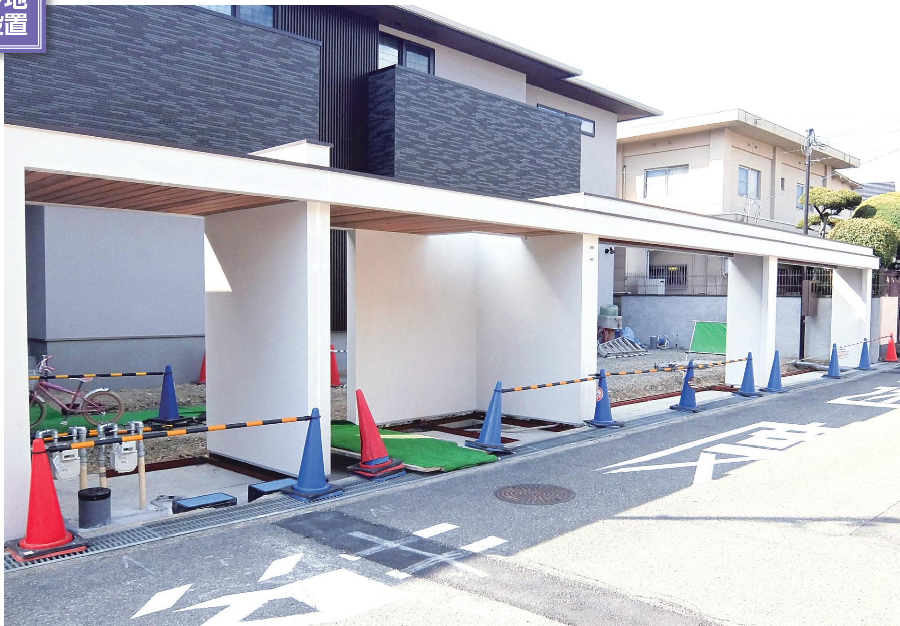
2台用シャッターゲートと通用門 3分割納入(全長18.4m)
