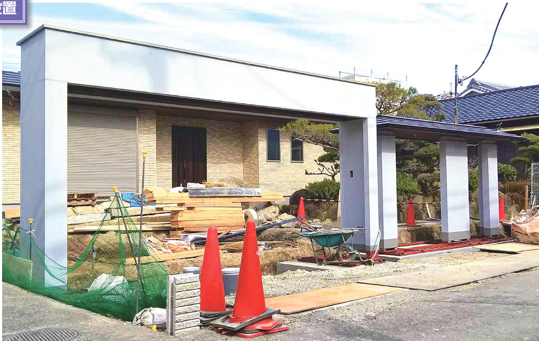
シャッターゲートは梁と柱を分割製造し、現場で連結作業を行いました。
