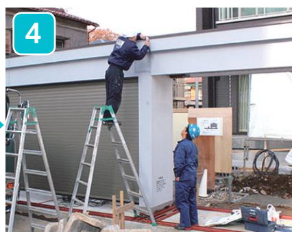
ドッキング箇所はボルトにて固定後、 蓋をします。(弊社にて)
