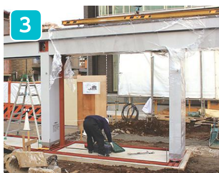
レベル調整確認 (弊社と現場工事店様にて)
