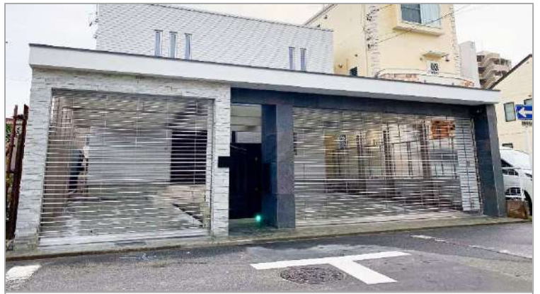
仕上げ施工後
