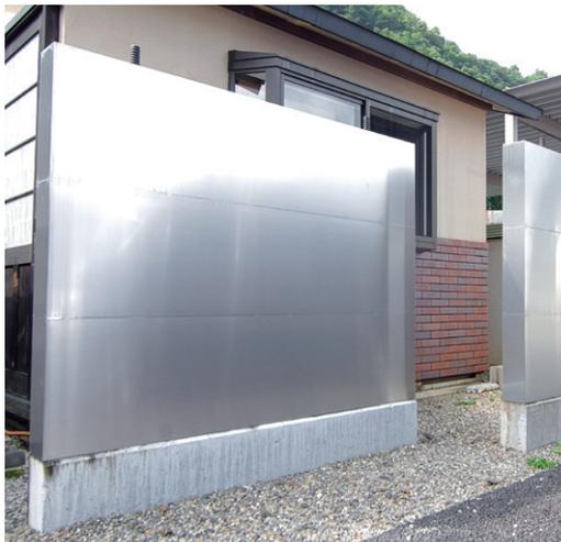
**金属製ハニカム構造**を採用し、準防火・防火地域にも対応。
