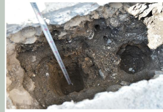
●穴の深さを確認してください。●穴の径φ180mm以上
