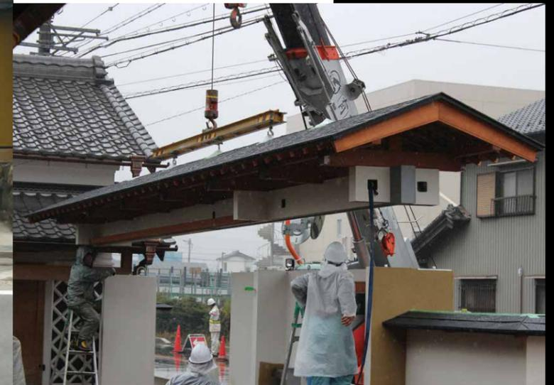
屋根(11000mm 屋根寸法) : W9100mm × H3500mm × D1400mm(2000) 3本片引き開口 : W4500mm × H2300mm 通用口引き違い開口(900mm) : W1800mm × H2000mm
