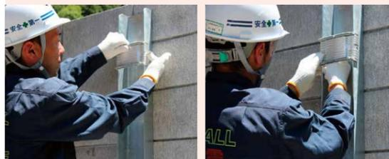
① 穴合わせとビスの差し込み ② 蝶ナットで締め付け固定
