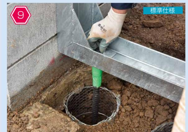
● ロックボルトパワースレッドに専用スペーサーを通し、専用ナットを締め付けて固定
