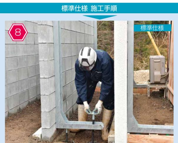
● 敷地側アングル支柱を通して杭基礎坑にロックボルト パワースレッドをセット
