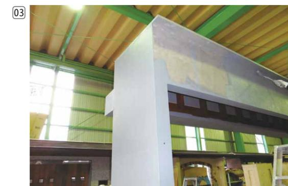
03 防水工程(5回塗り) GL下トップコート及びエポキシ処理
