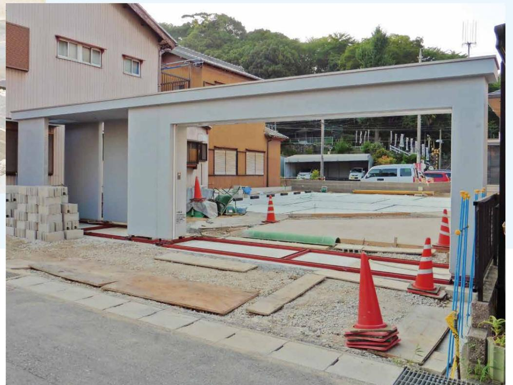
4tユニック車 + 4tユニック車にて搬入・据付け 全長10m超えも可能(分割納入)
