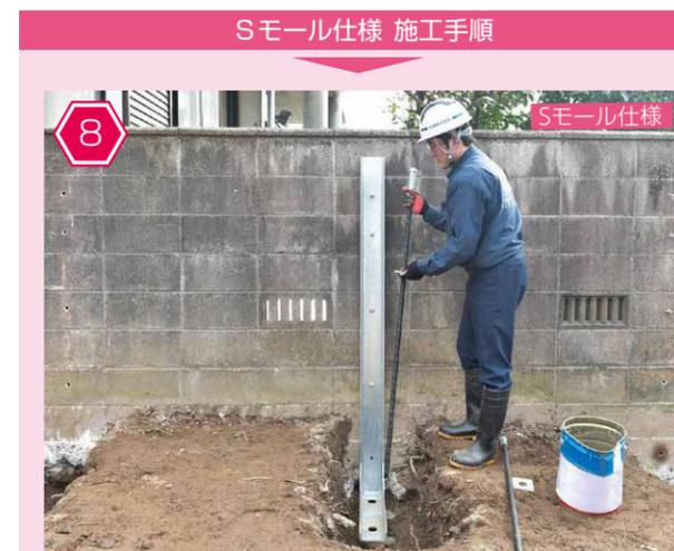
● 敷地側アングル支柱を通して杭基礎坑にロックボルト パワースレッド (L1,500mm) をセット
