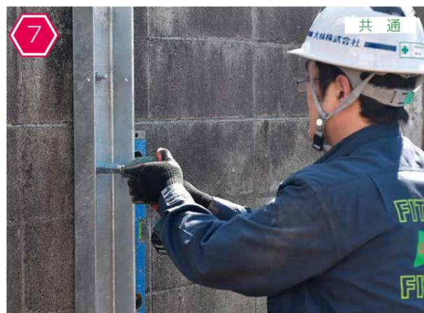
● 敷地側アングル支柱をセット。角根丸頭ボルトにワッシャーを通しナットを敷地側から締め付けて固定
