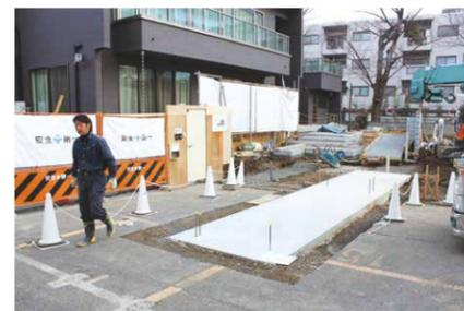
① 基礎図に従いコンクリートベース基礎の打設及び溶接用鉄筋の立ち上げ (現場工事店様にて)
