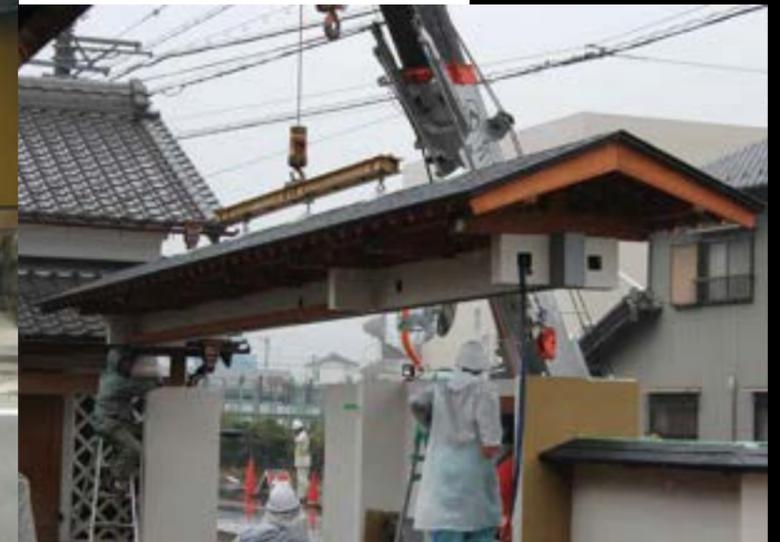
屋根(11000mm 屋根寸法) : W9100mm × H3500mm × D1400mm(2000) 3本片引き開口 : W4500mm × H2300mm 通用口引き違い開口(900mm) : W1800mm × H2000mm ※3分割にて現地納入します。大型ラフターで据付
