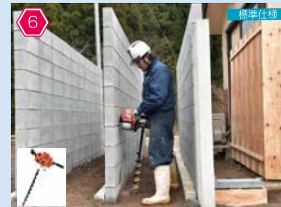
● エンジン式アースオーガーによる穴掘り作業(P18参照)
