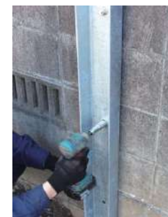
●インパクトドライバーで Tロックアンカーを取り付け 完了です。
