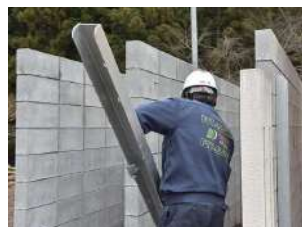
※写真は最重量、18型敷地側 アングル支柱(31kg)です。
