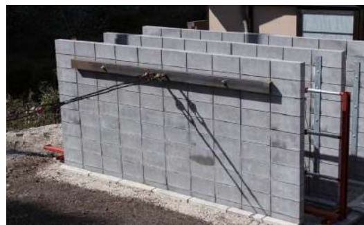
(天端から300mm下がりワイヤーを取り付け牽引)
