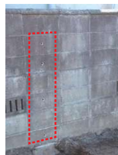
●Tロックアンカー用の穴あけ (振動ドリル)φ13mm
