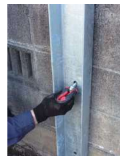
●敷地側にアングル支柱を置き Tロックアンカーをセットします。
