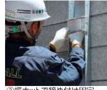
②蝶ナットで締め付け固定
