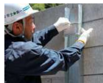
①穴合わせとビスの差し込み
