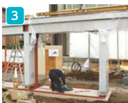
レベル調整確認 (弊社と現場工事店様にて)
