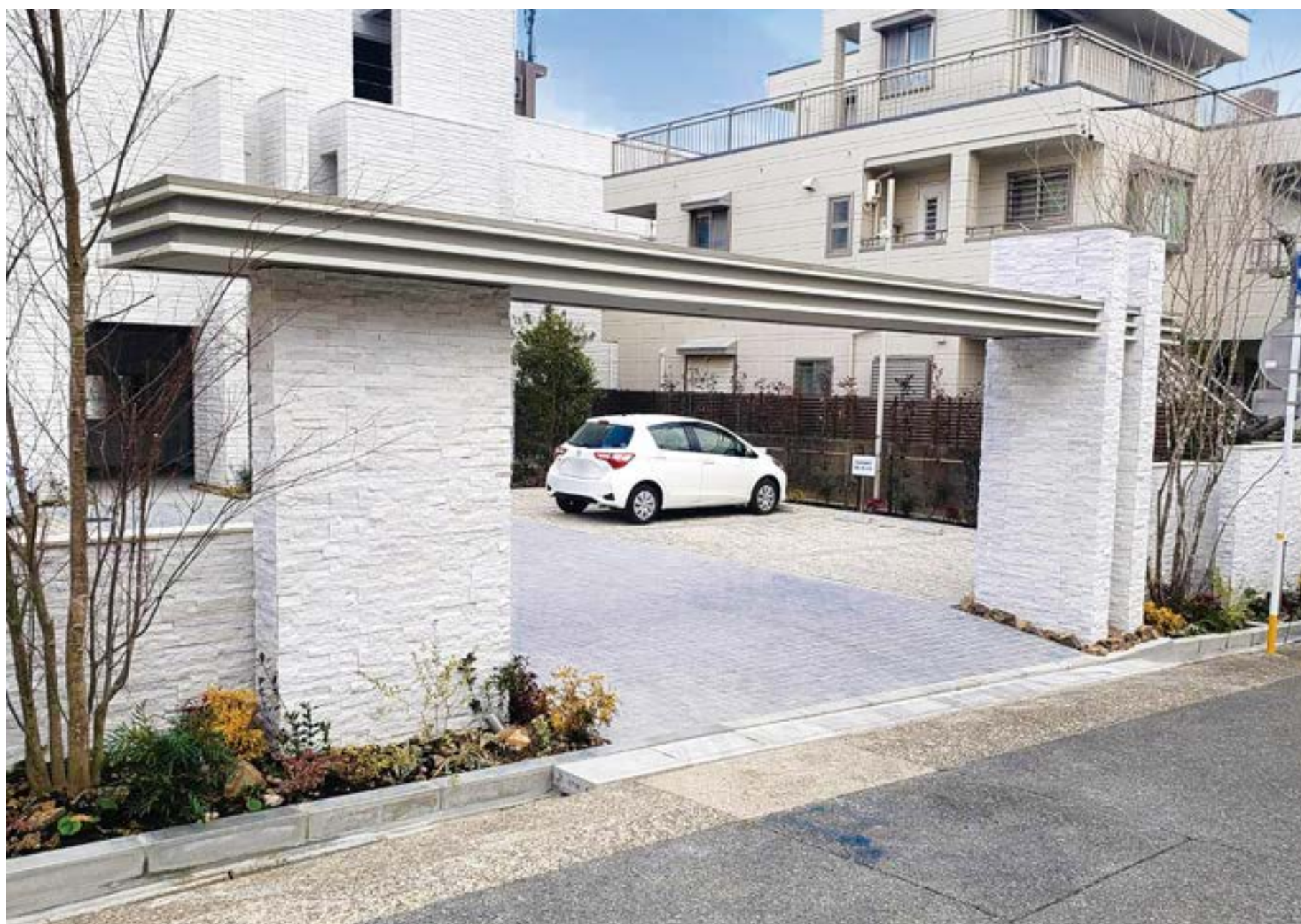
賃貸住宅のエントランスゲート 約W8,720×H2,825mm(屋根寸)。設置時間は約4時間。
