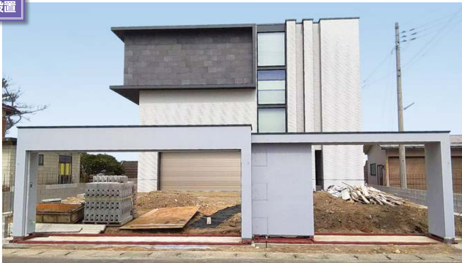
シャッターゲートと通用門を一体化したゲート。 約W11,140×H2,825mm。設置時間は約3時間半。
