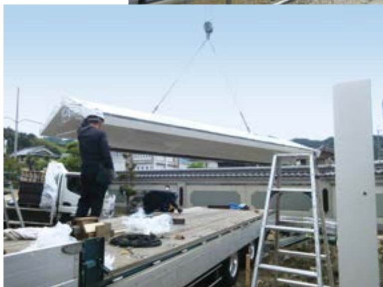
FIT迎門 約W7,420×H3,470mm(屋根寸) 設置時間は約6時間半。
