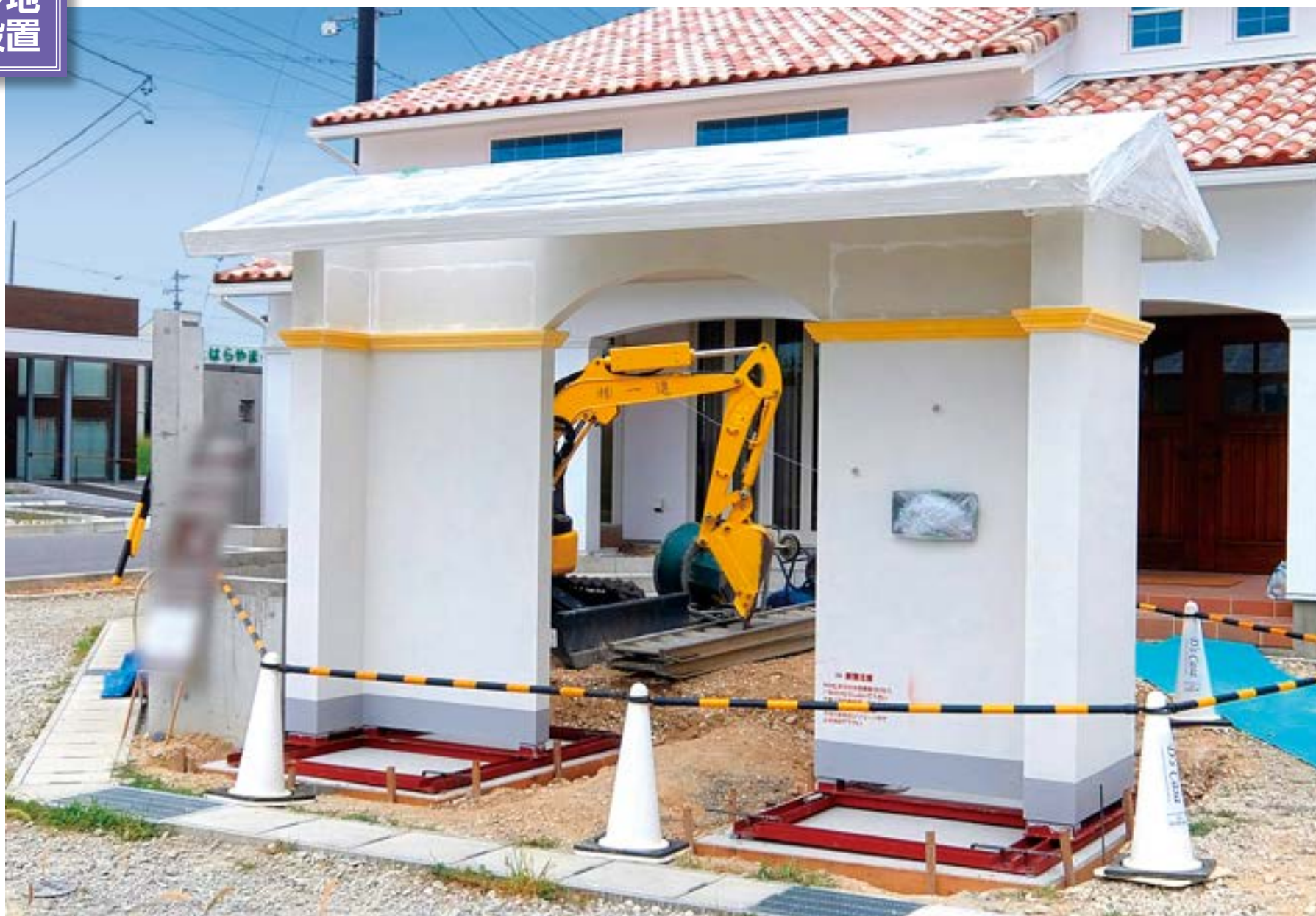
FIT迎門 約W4,800×H2,900mm(屋根寸)。設置時間は約3時間。屋根は一部をくり抜いて製造しました。
