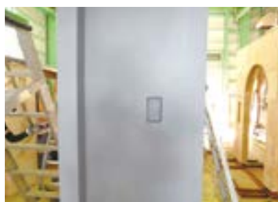
シャッタースイッチ箇所凹まし加工
