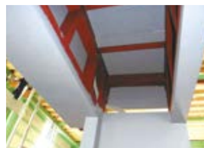
PF管埋設加工
