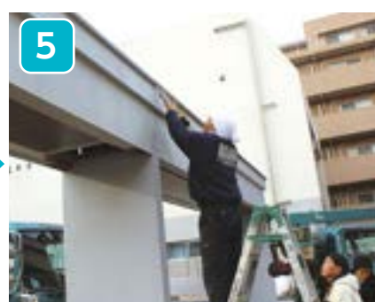
ドッキング箇所を変性シリコンで 下地調整(弊社にて)
