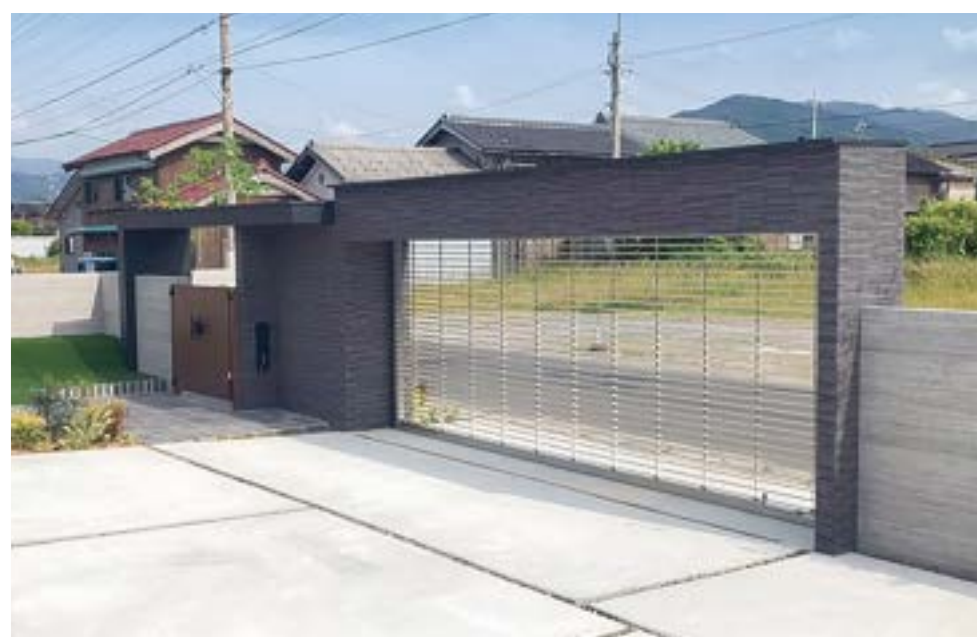
圧迫感を感じさせないクローズ外構に仕上げて頂きました。 通用門のL字に折れた部分に支給品の埋込ポストを工場内で 取り付け製造し、使い勝手の良い機能的なゲートが出来上がりました。
