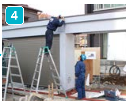
ドッキング箇所はボルトにて固定後、 蓋をします。(弊社にて)
