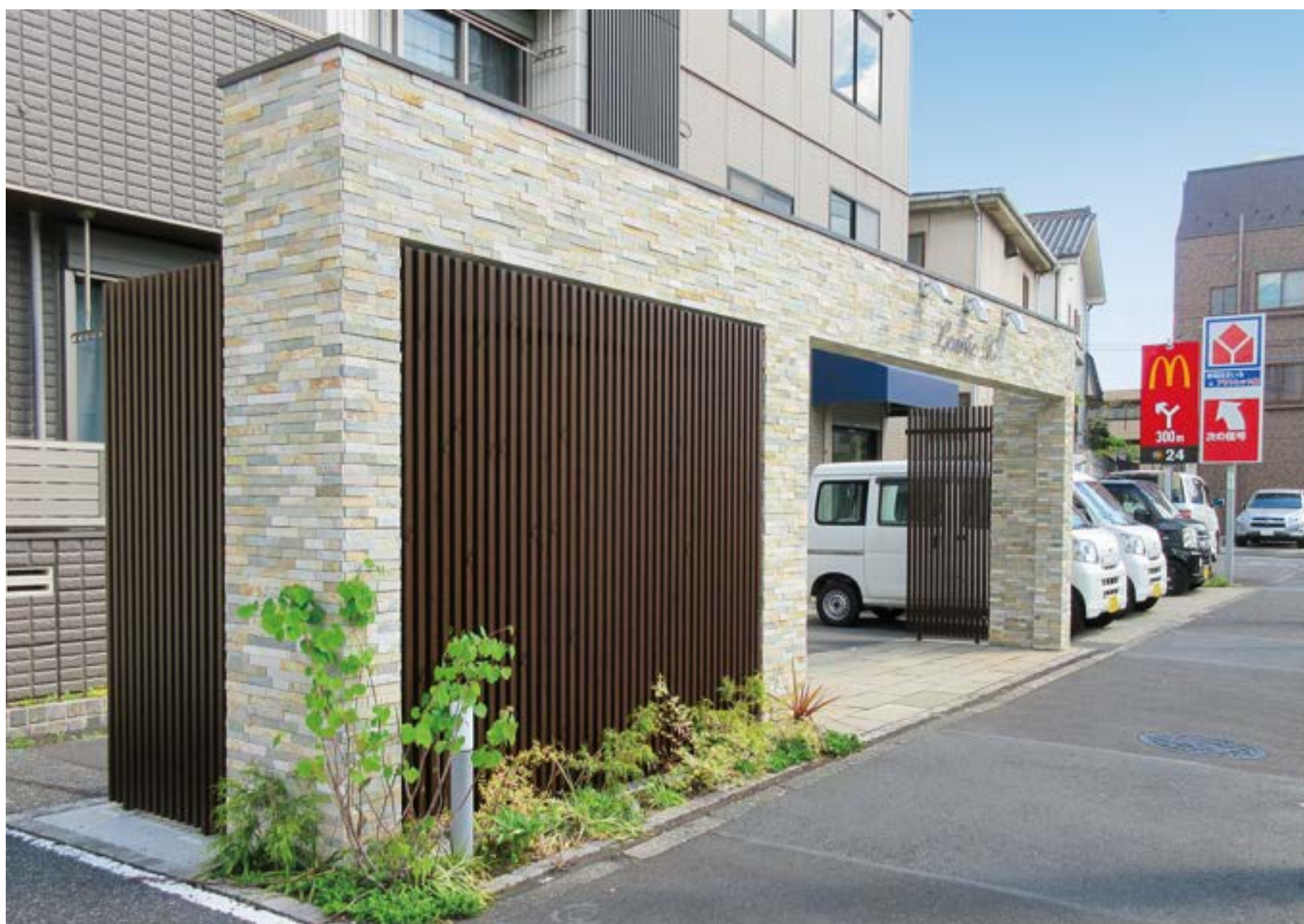
賃貸住宅のエントランスゲート 格子は躯体設置後に工事店様にて取り付けられました。 約W8,000×H3,000mm
