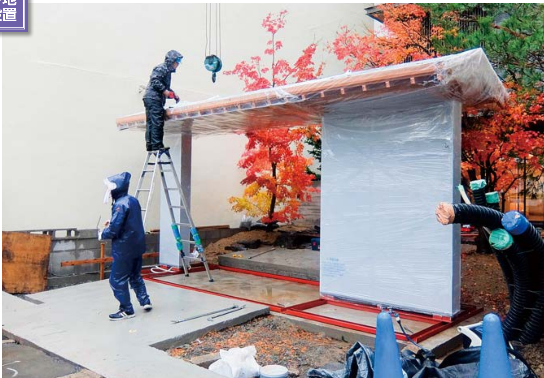
FIT迎門 約W6,100×H3,100mm(屋根寸)。 設置時間は約3時間。
