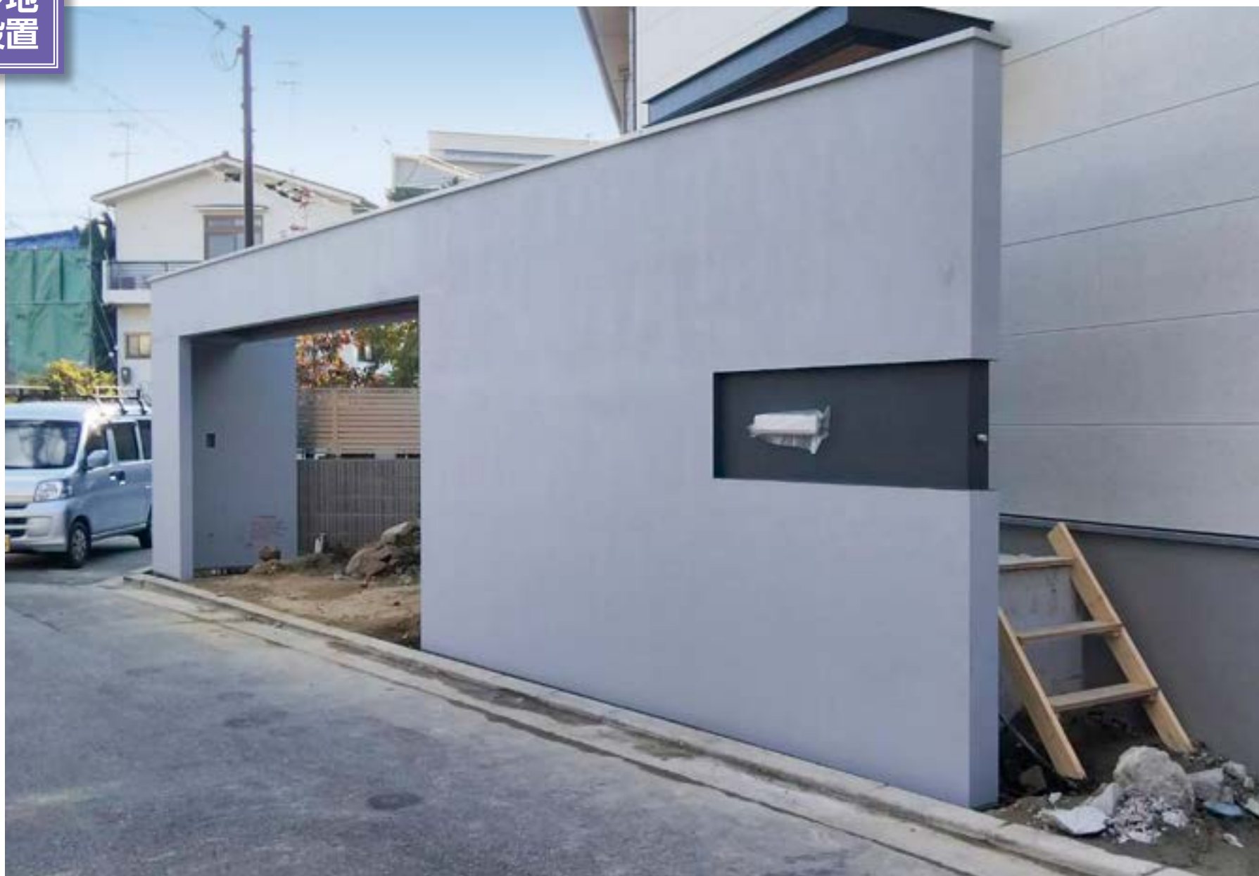
約W10,550×H2,925mmの大型ゲート。設置時間は約5時間。
