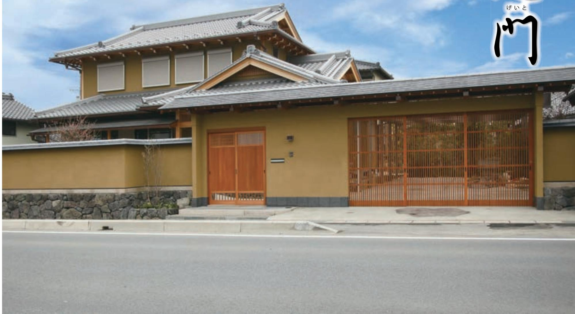
屋根 (11m 屋根寸法) : W9.1m × H3.5m × D1.4m(2.0m) 3本片引き開口 : W4.5m × H2.3m
