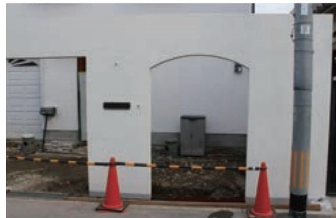
5 パーツ分割納入、分割箇所ボルトで連結をします
