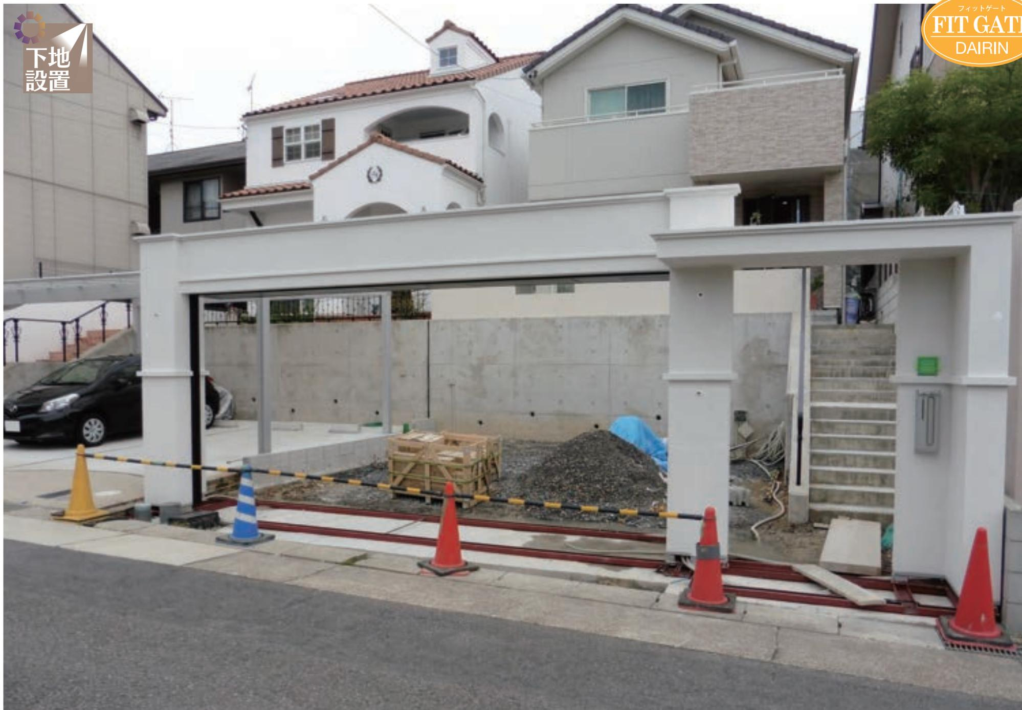
4 t ユニック車 + 2 t ユニック車にて搬入・据付け [支給備品：ポスト+電気錠用テンキー]
