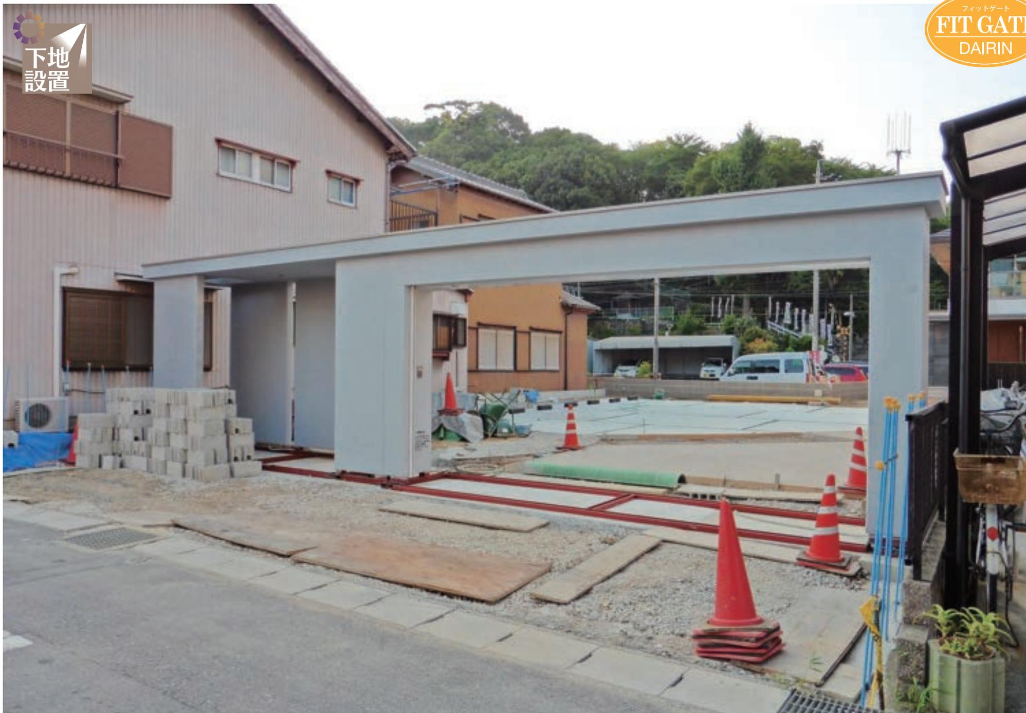
4 t ユニック車 + 4 t ユニック車にて搬入・据付け \*鉄骨構造なので壁用石材の施工が可能です。
