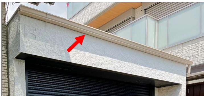
シャッターゲート躯体で、背面にカーポートを設置しない等の場合、シャッターゲート屋根から水が滴るのを防ぐため雨樋を取り付けることが可能です。
