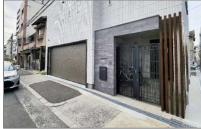
△仕上げ施工後
