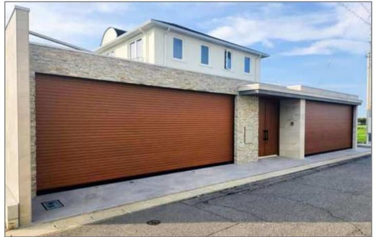
シャッターゲート2棟と通用門、背の高い壁を一体化させた大型ゲートを製造納品させていただきました。分割製造し、すべての躯体を半日で連結させました。
