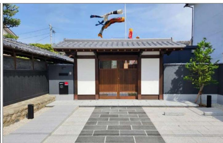
数寄屋門 切妻5型で袖壁や建具デザインを変更した特注品を製造納品させていただきました。袖壁をシンプルな塗り壁仕様にした代わり屋根を総瓦葺きにしたことで重厚感が際立ちます。約W5,250×H2,915×D1,900mm (瓦含む屋根寸) 設置時間：約3時間
