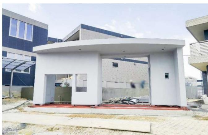
愛知県某所に新たにつくられたマンションのエントランスゲートとしてFIT GATEが採用されました。曲線を描いた屋根や集合住宅用のポストを取り付けられるように設計されたFIT GATEならではのデザインのゲートで、躯体をスライスするような形で前後で分割し、現場で連結させました。躯体設置後、工事店様により壁仕上げや後付けでポストなどの取付など仕上げ施工が行われ、ナチュラルな雰囲気の高級感あるエントランスゲートに仕上げていただきました。
