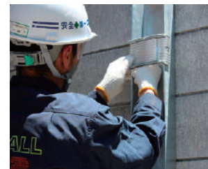
②蝶ナットで締め付け固定
