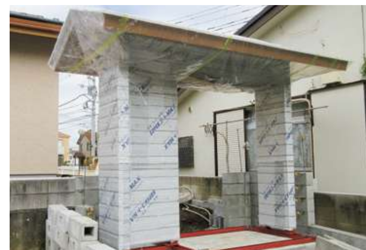
▲防水下地のうえ、ラス網加工にて納品（モルタル塗り別途）
