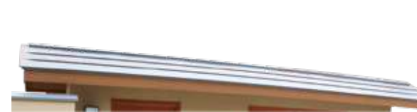
ガルバリウム鋼板葺き (横一葺き)
