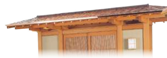
純銅板葺きと棟のみ瓦葺き (素丸瓦葺き)
