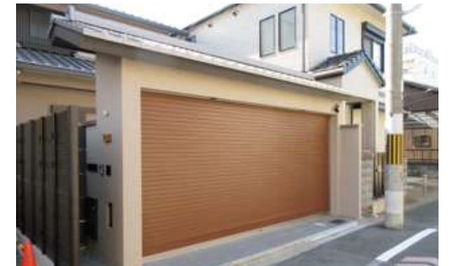
仕上げ施工後
