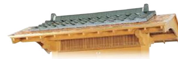
純銅板と瓦の合葺き (一文字瓦葺きと銅板一文字葺き)
