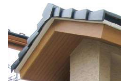
▲破風及び天井材は木調防火サイディングを使用
