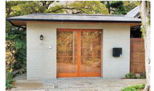
仕上げ施工後
