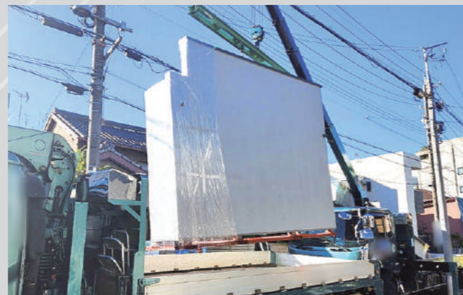
△ FIT HIGH-WALLの納品中
