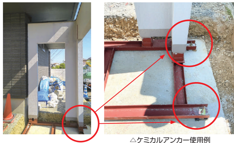
△ケミカルアンカーを用いた場合の基礎図(例)
