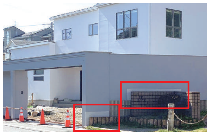
△一部分のみジョリパット塗り <ローラー仕上げ>
