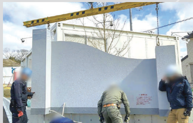
△ FIT WALLの納品中
