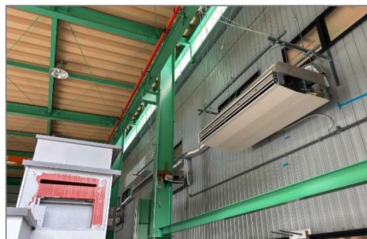
△新たに設置されたエアコン
